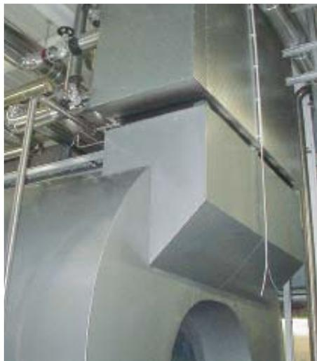
Economizzatore montato sulla caldaia Vitomax 200-HS
